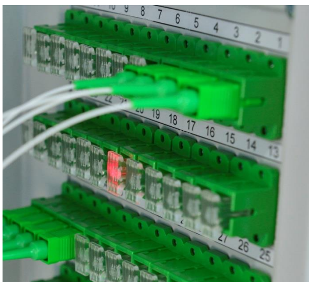
Listwa komutacyjna przełącznicy z przezroczystymi zatyczkami
